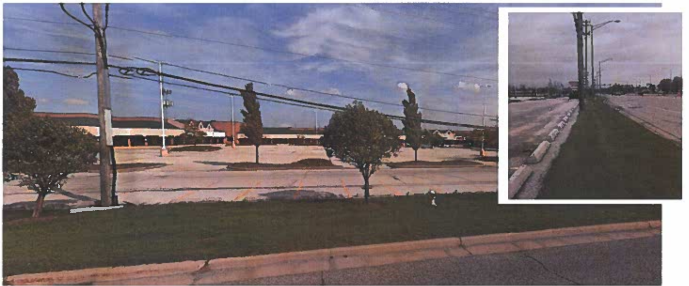
HARLEM AVENUE FRONTAGE
